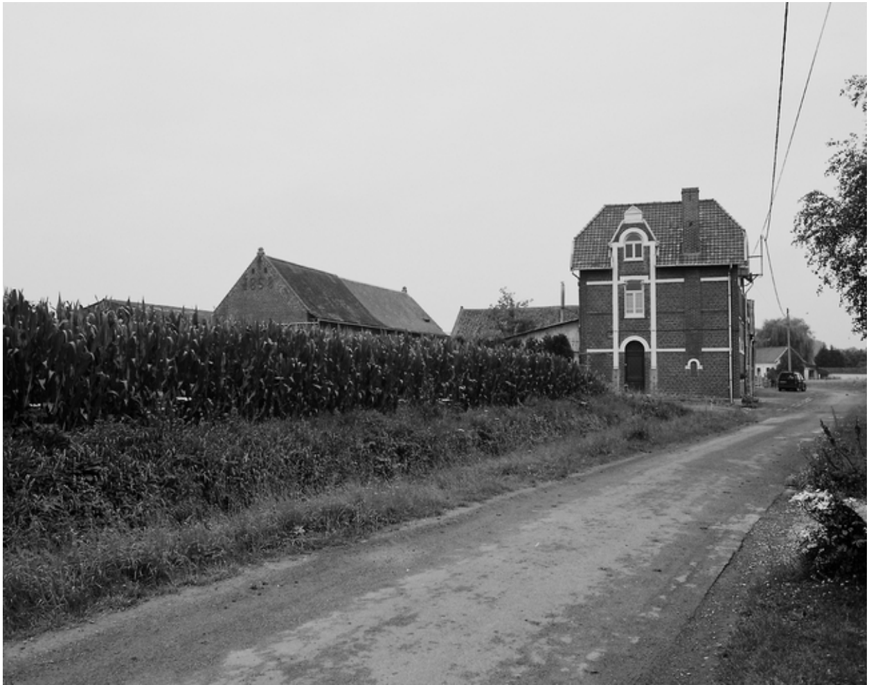
Vue générale latérale : logis reconstruit et grange.
