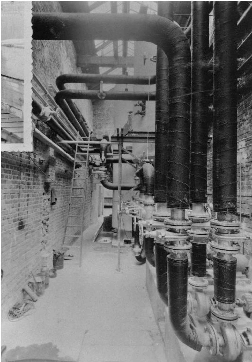
Tuyaux d'épuration, juillet 1953 (coll. part.).
