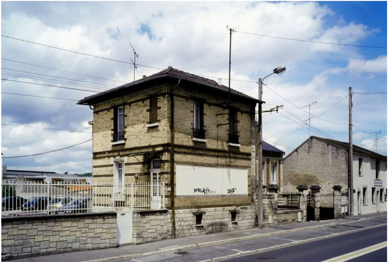
Bâtiment administratif et logement de l'usine.
