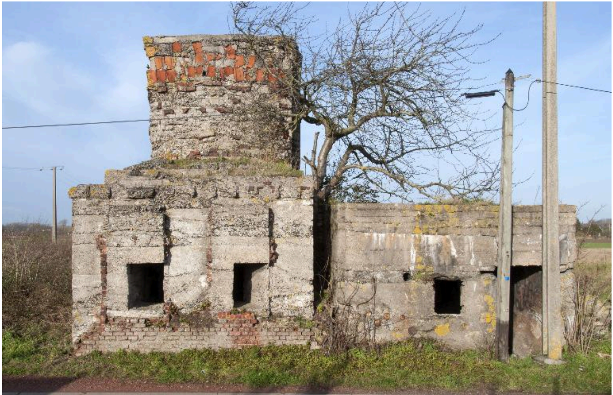
Casemate a. Elévation antérieure sur la rue de Bouchaine, vers le nord
