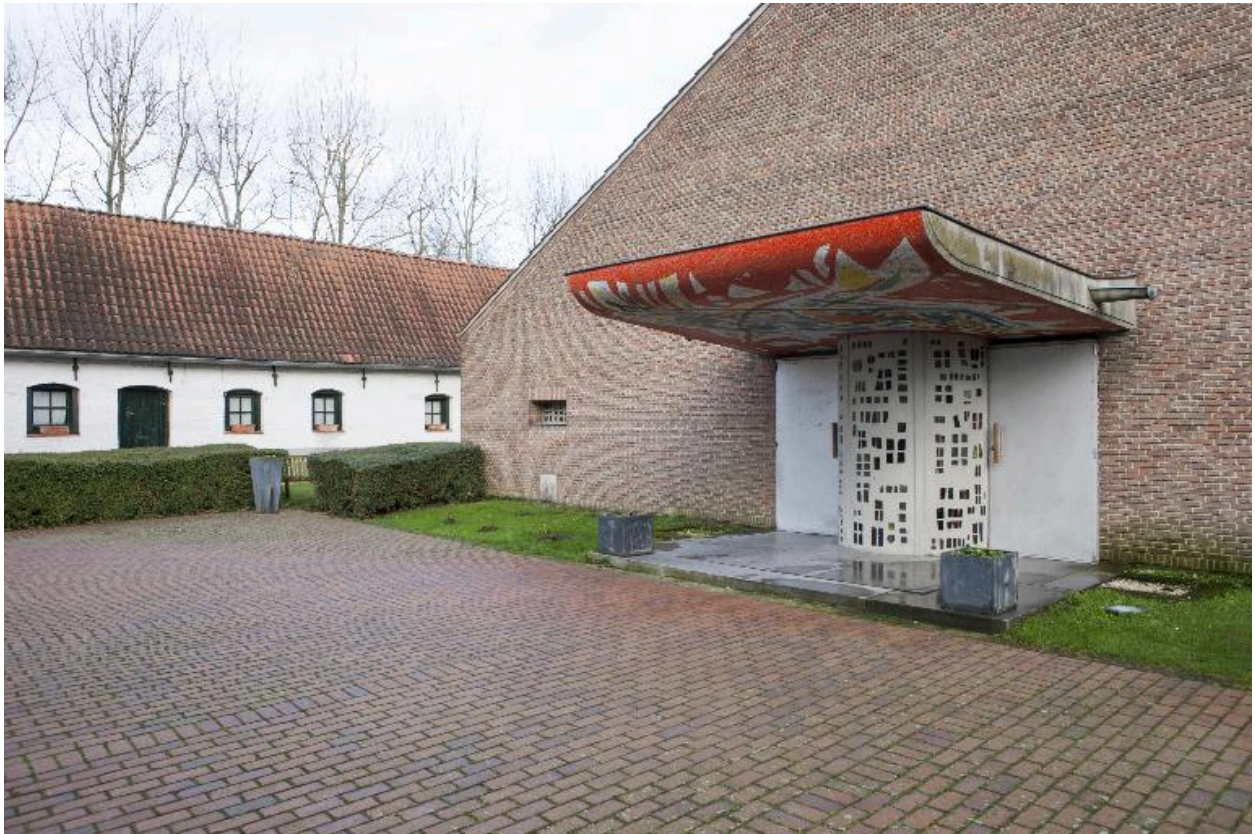
Vue de la porte d'entrée et une ancienne ferme.
