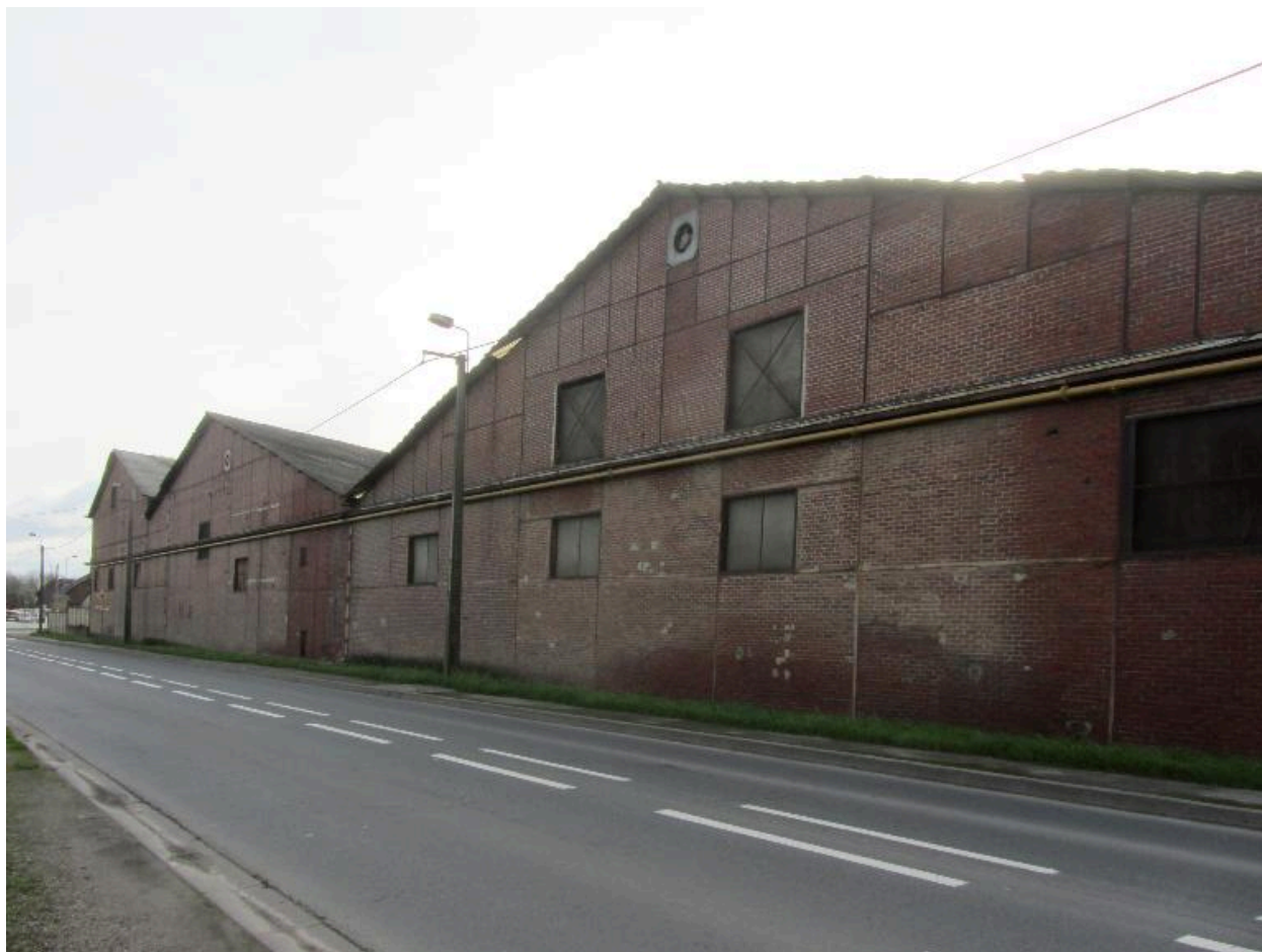
Détail des pignons sur rue des ateliers de fabrication.
