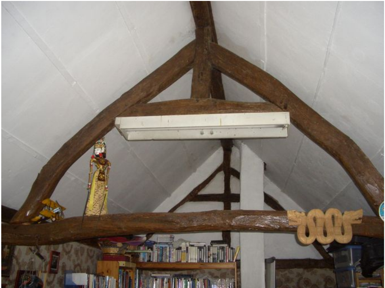
Vue de la charpente de l'annexe.
