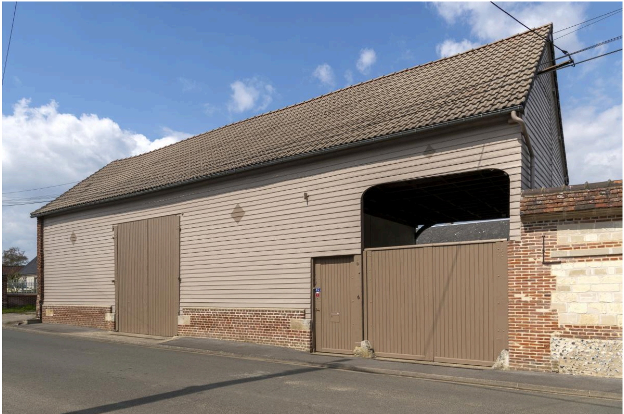
Ancienne grange essentée en bois, n°14 rue de Bonlier, vue depuis le sud.
