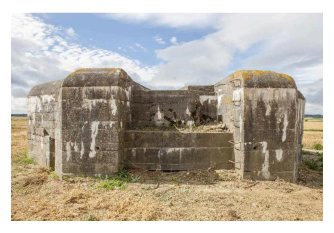
Elévation nord. La banquette de tir, accessible par échelons métalliques, comprend, au centre la position du mitrailleur et à droite, celle du servant
