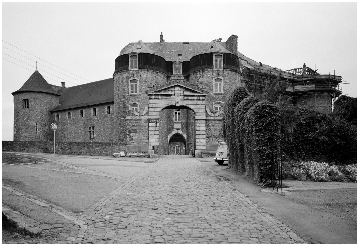
Vue générale de la rue de Bernet.
