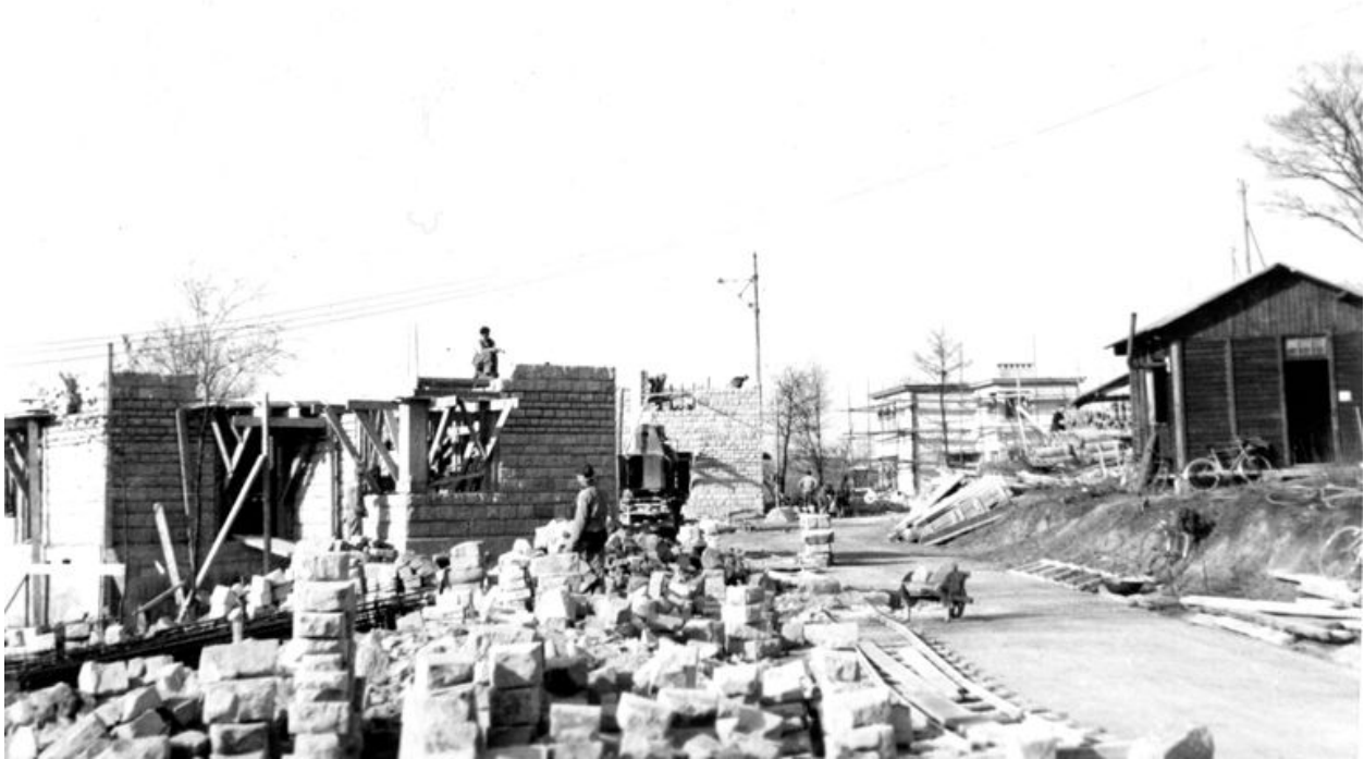
Construction des logements pour les employés du Cerchar, vers 1950 (archives d'entreprise).
