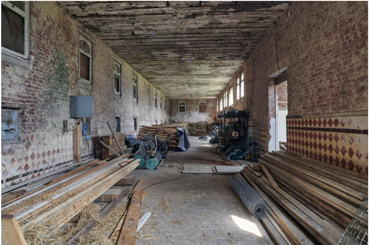
Intérieur de la grande étable, vue vers l'ouest.
