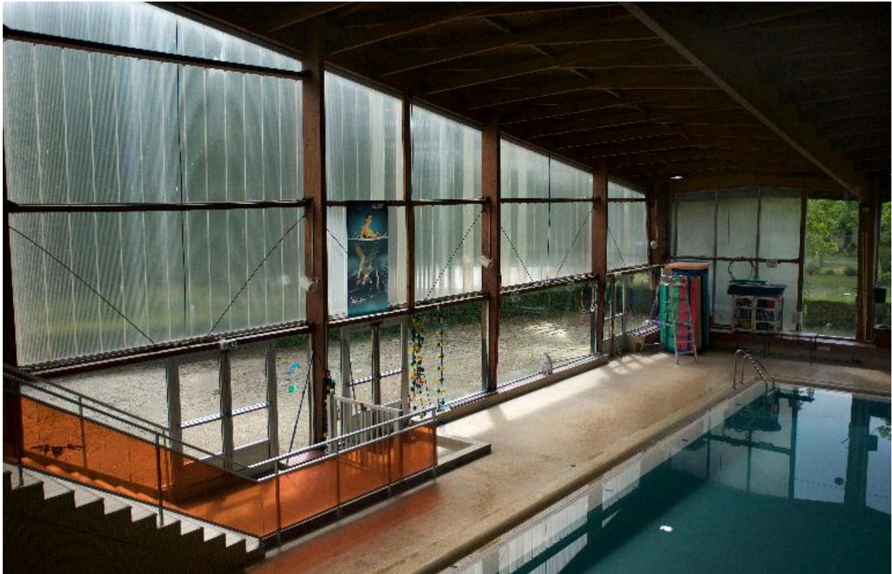
Vue du pignon est, vitré en partie basse et surmonté d'un bardage translucide en partie haute.
