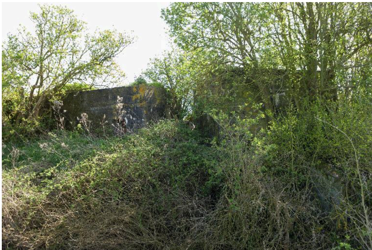
Vue arrière, vers le sud-est des bâtiments 1 (à droite) et 2
