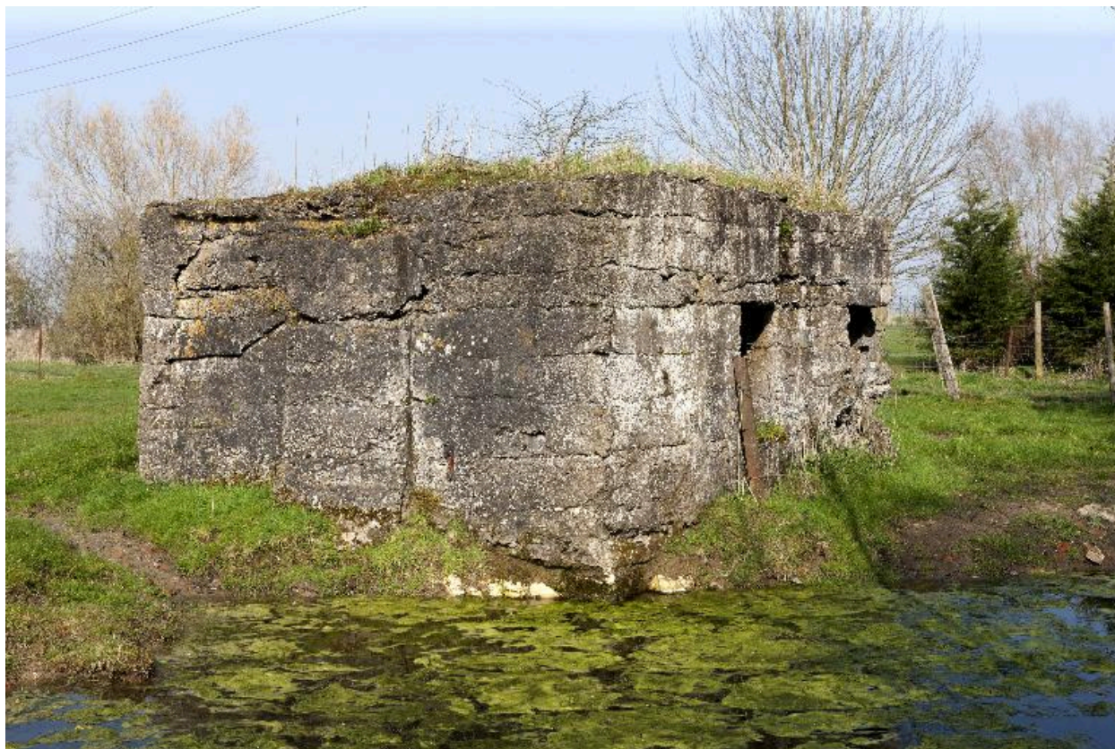
Vue de trois-quarts vers le nord-est
