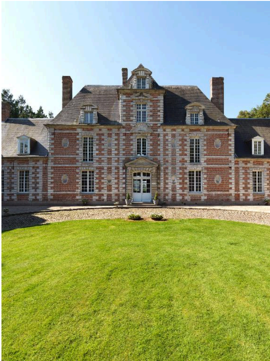
Façade du corps de logis principal sur cour.
