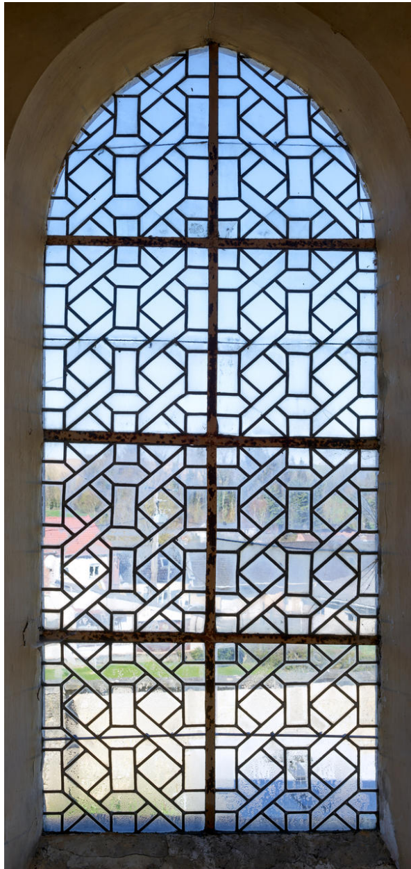
Verrière (baie 5) : verrière à borne.
