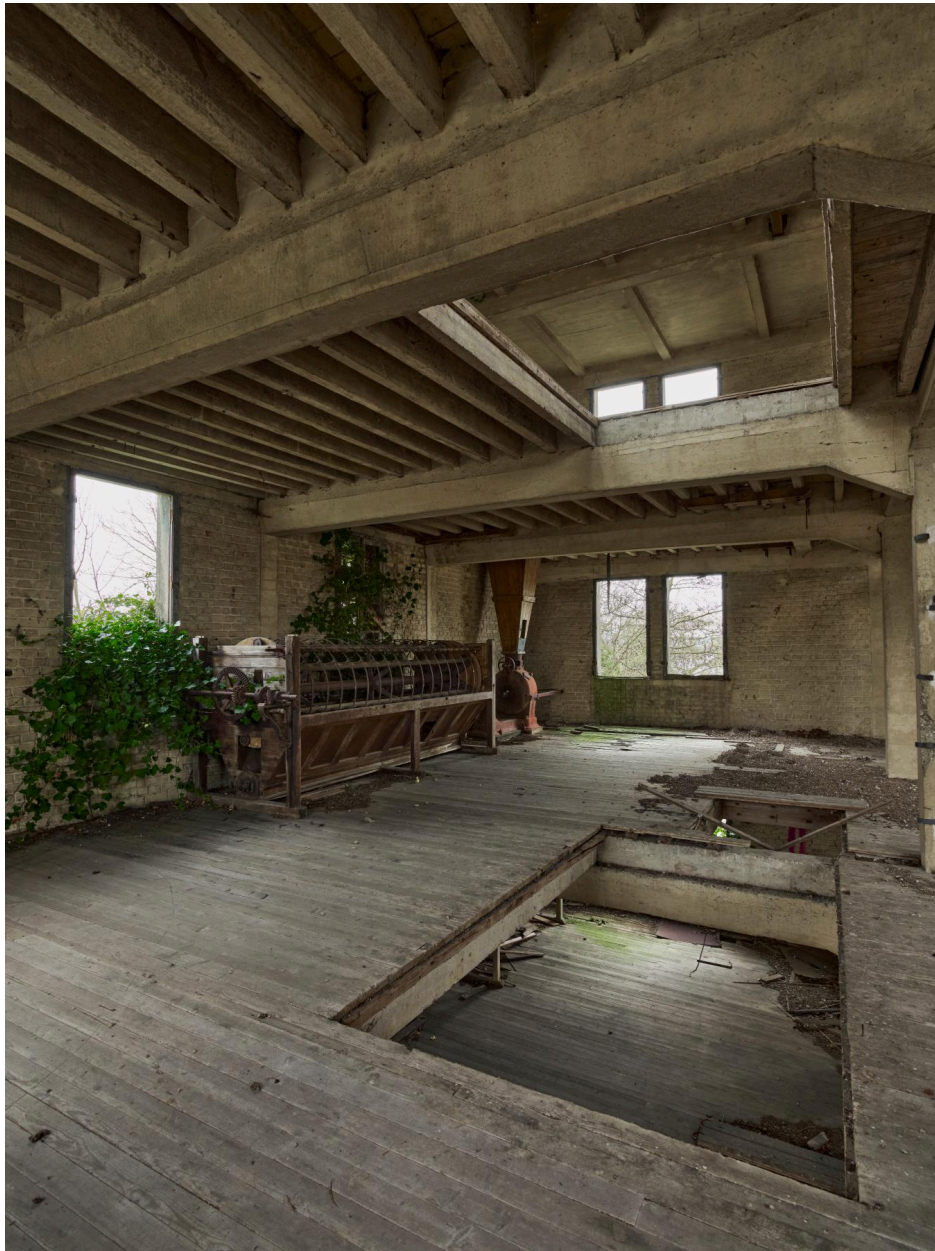
Ancienne salle des plansichters.
