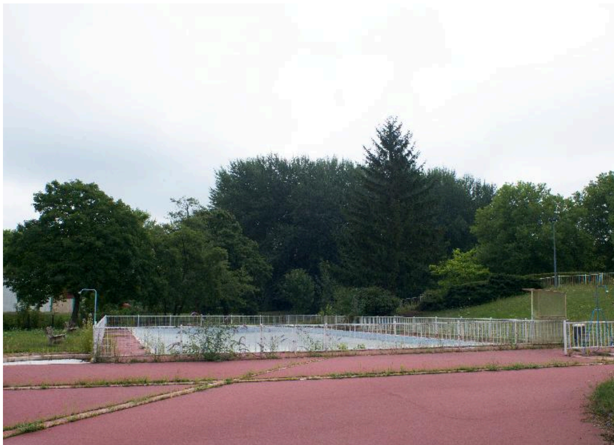
Bassin extérieur de 25 mètres (construit en 1971).
