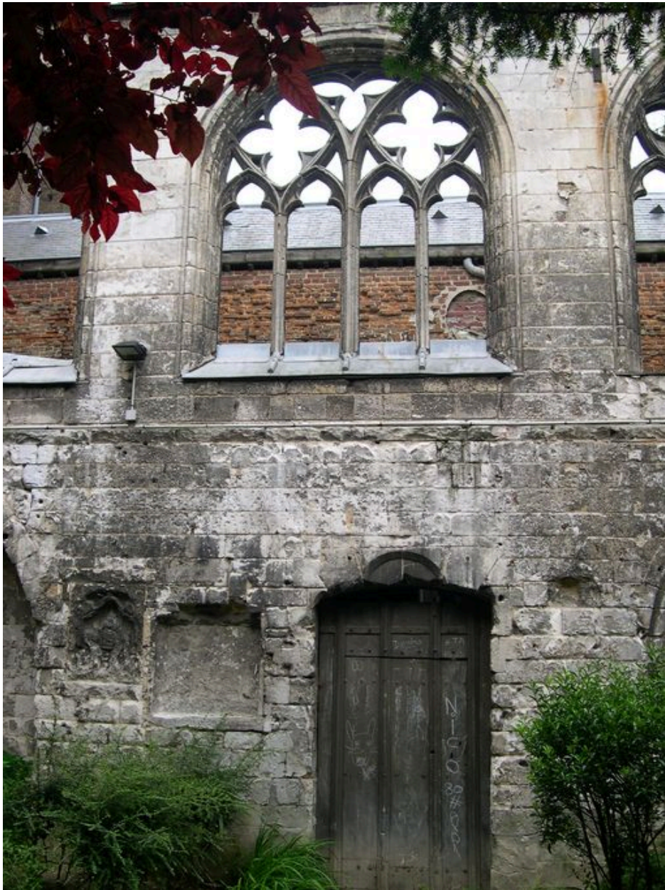
Vestiges de l'ancienne église conventuelle, vue intérieure baie du mur sud.
