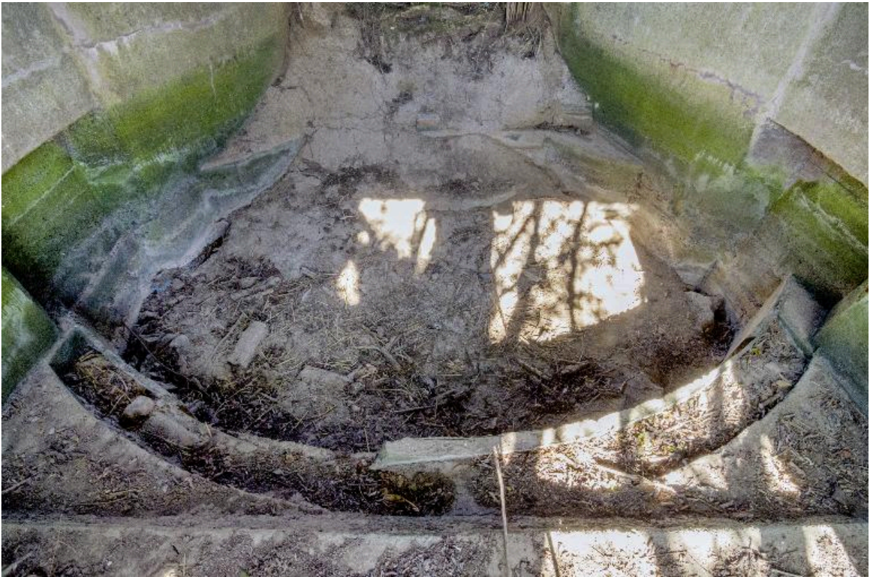
Vue intérieure vers le sortie de la chambre de tir avant déblaiement.
