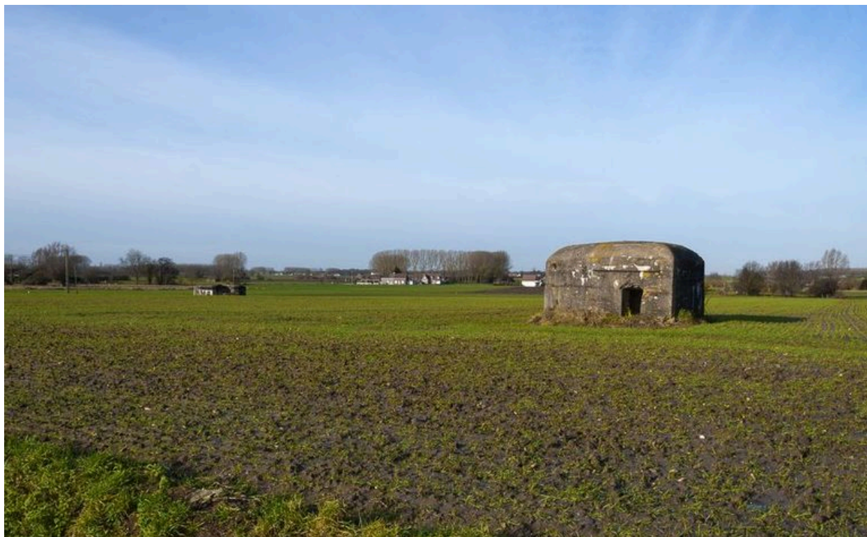
Vue générale vers le nord-ouest. Au second plan, une casemate à mitrailleuse (IA59004897)
