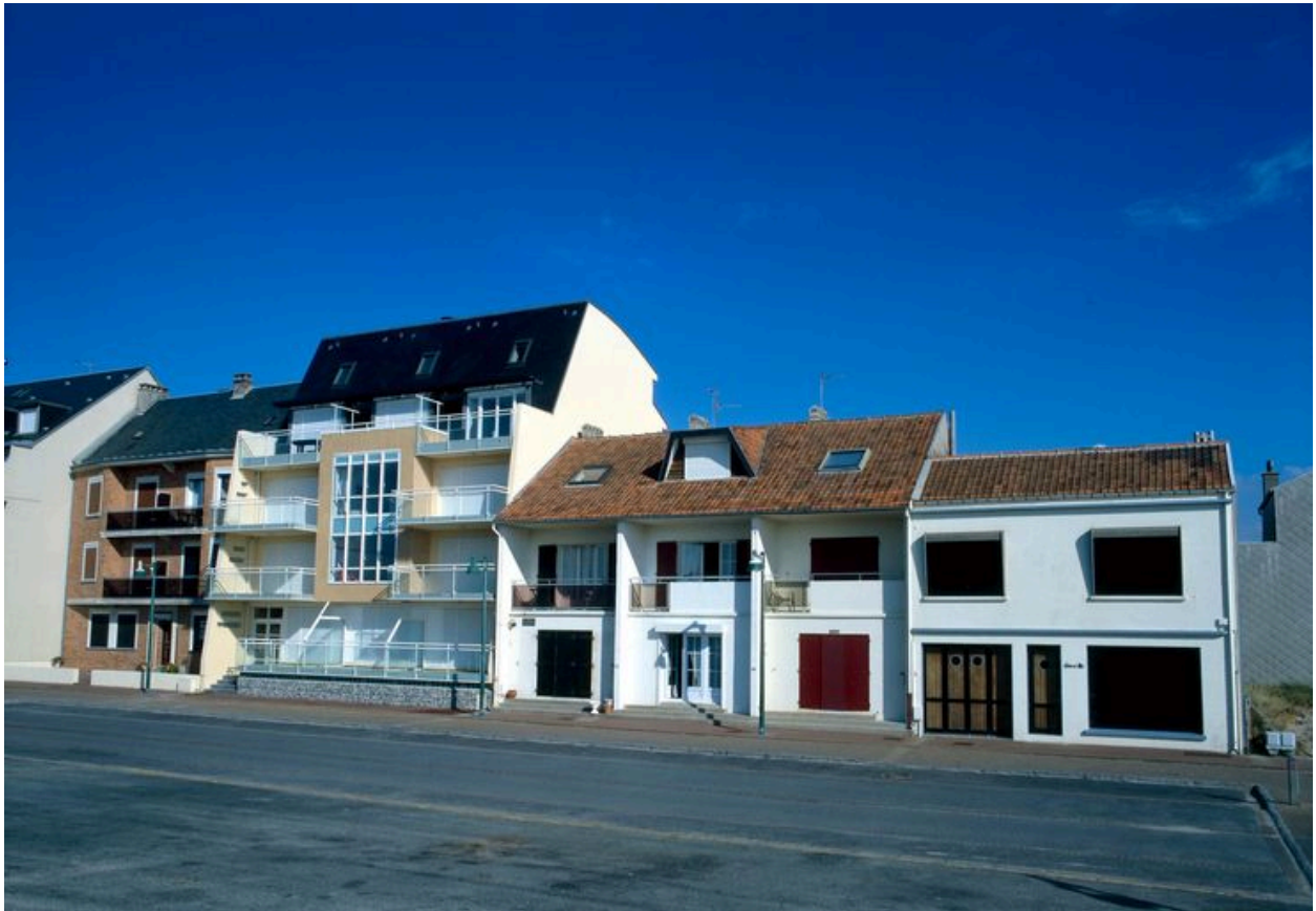
Les constructions de la digue nord.
