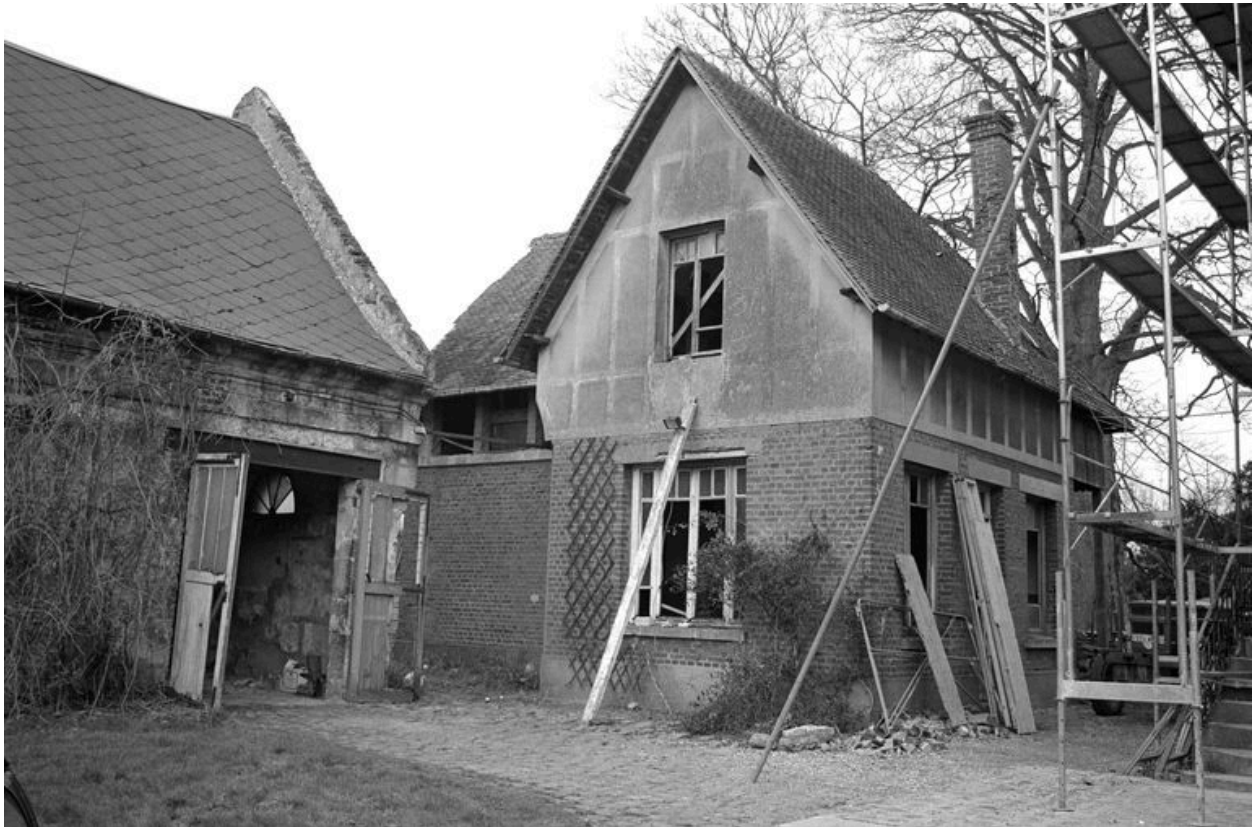
Laiterie annexée au logement patronal : façade postérieure.
