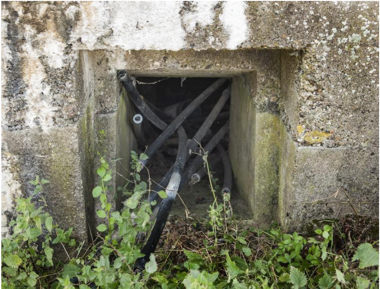
Ouverture dans l'élévation nord
