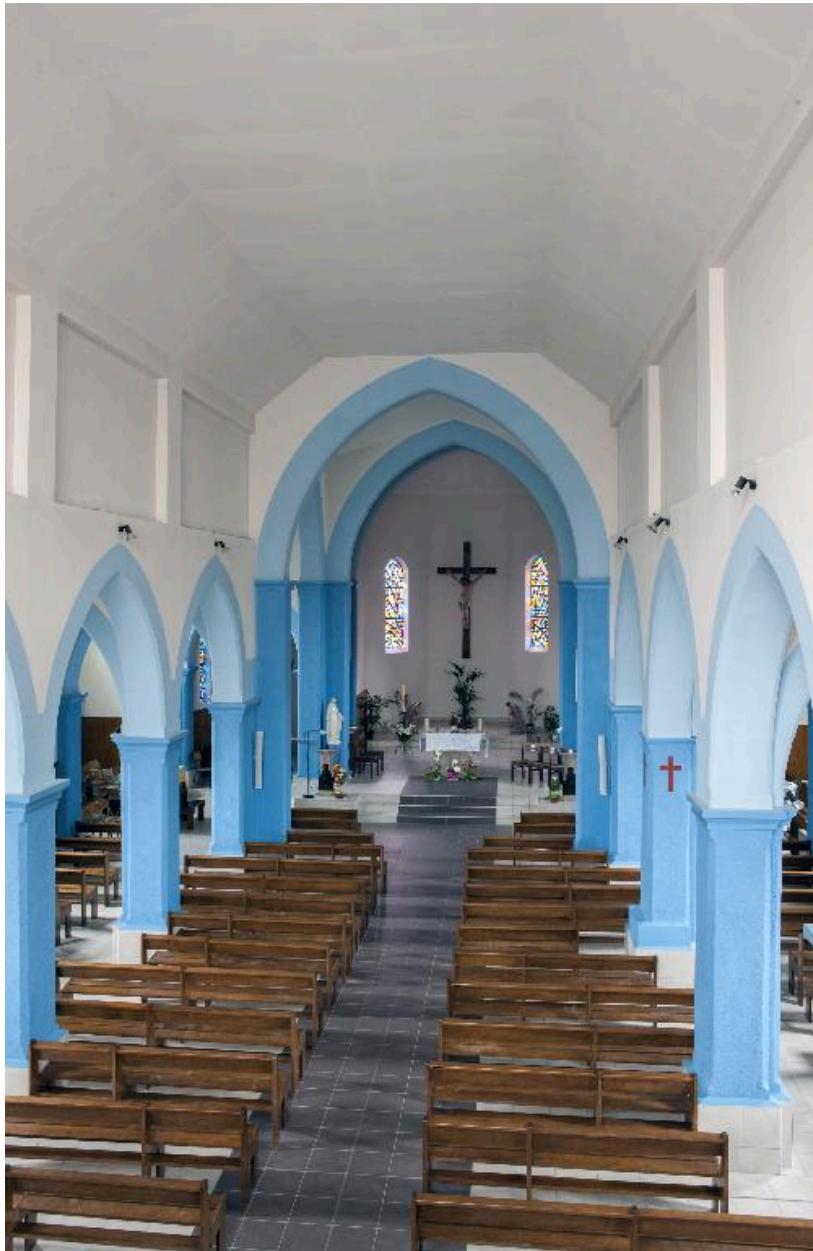
Vue générale intérieure vers le coeur depuis la tribune.
