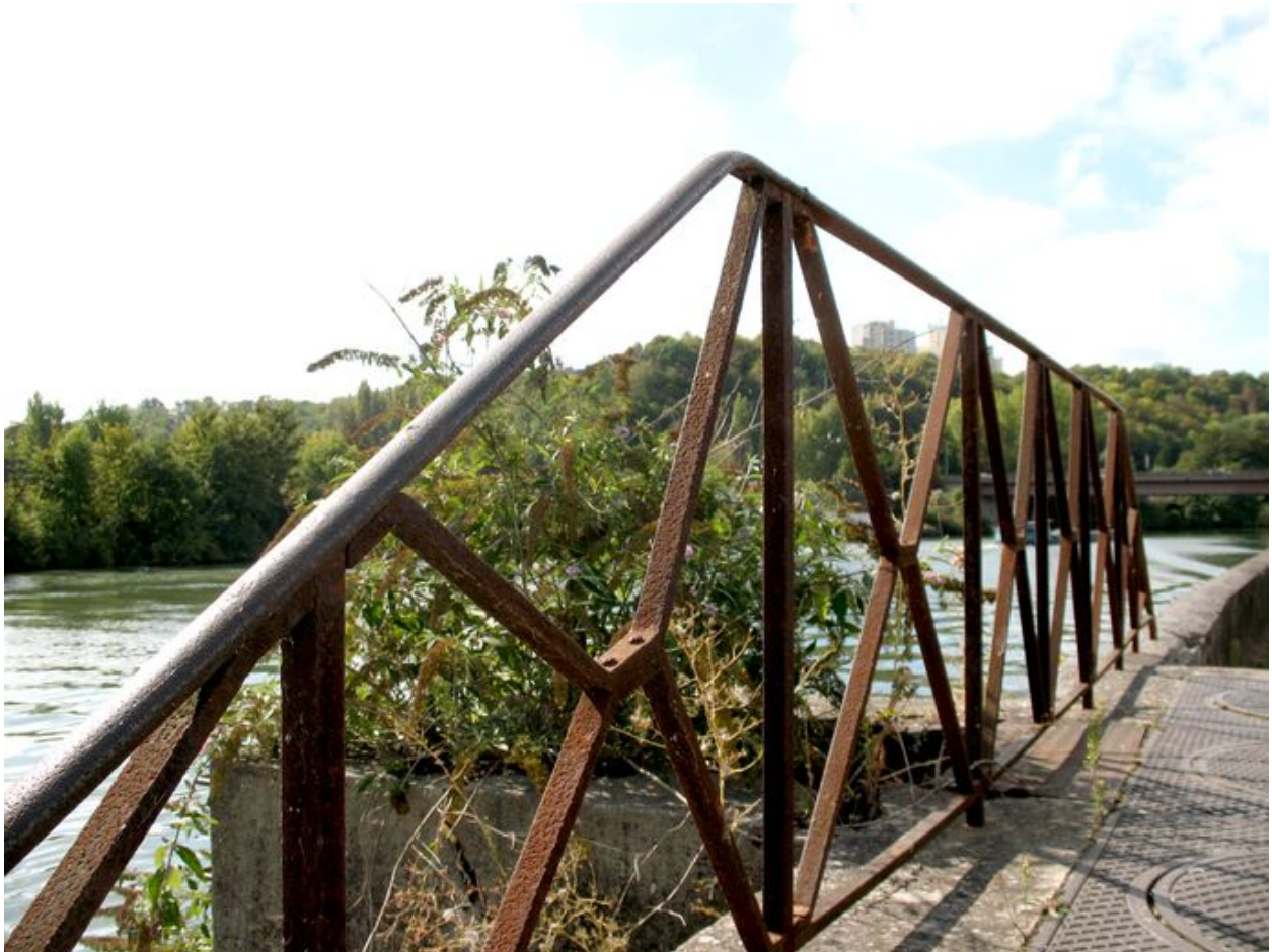
Détail du garde-corpe en fonte.
