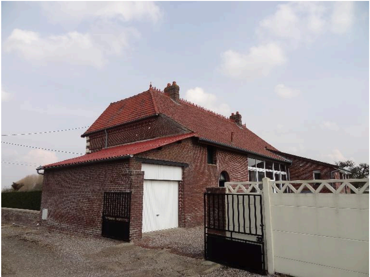
Vue de trois-quarts arrière de la maison patronal de l'ancienne briqueterie Wargnier.
