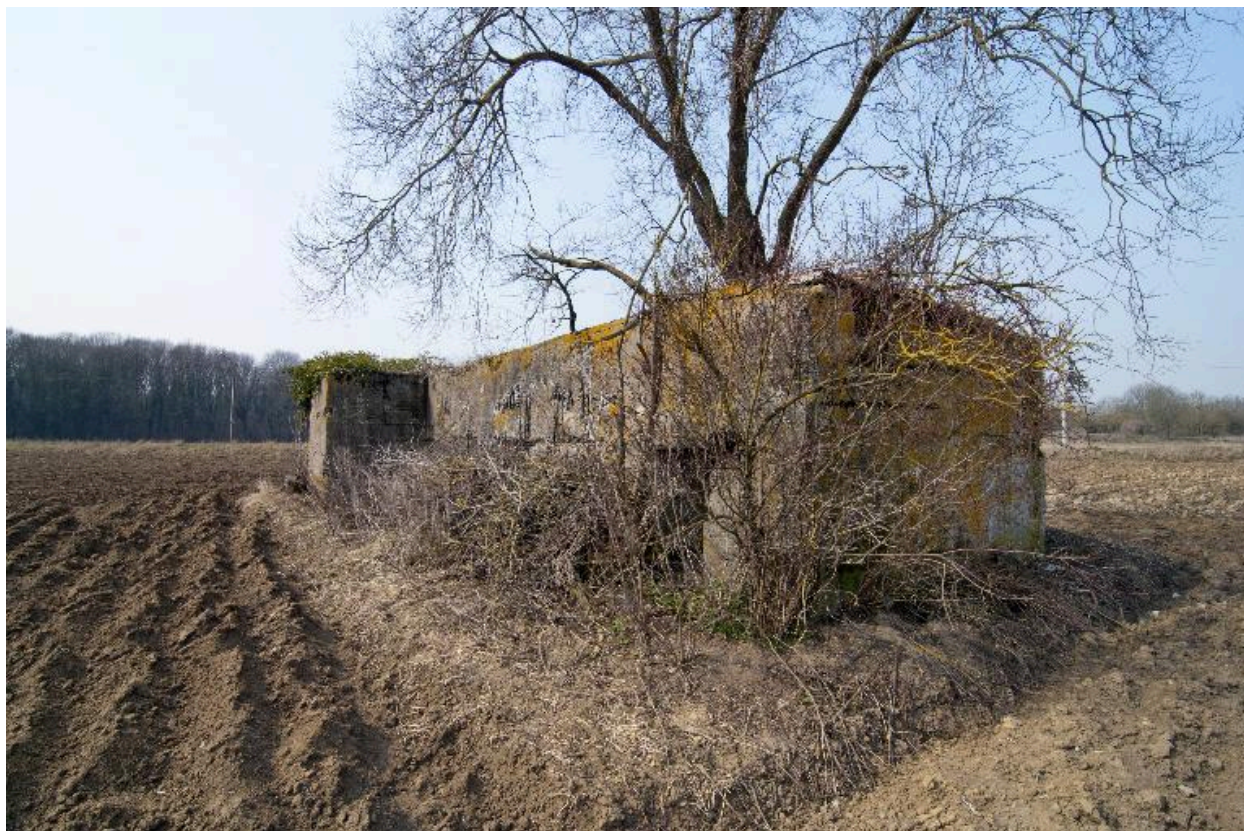
Vue générale, vers le nord-ouest
