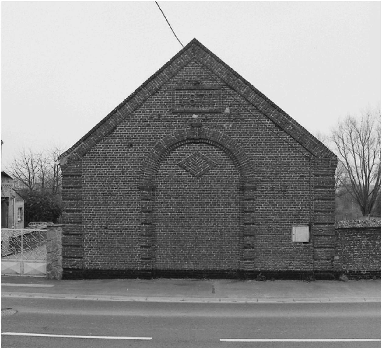
Le pignon de la grange située 869 Grand'Rue.
