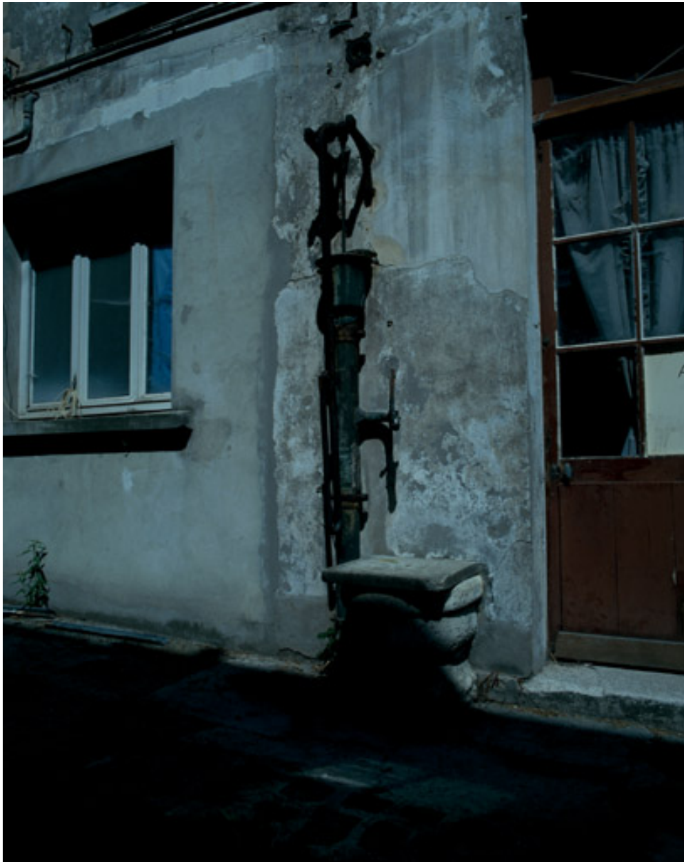
Pompe à eau dans la cour.
