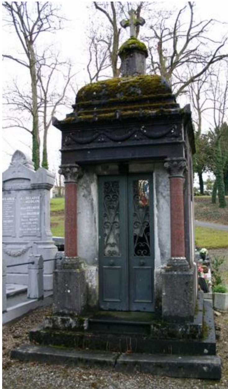
Vue générale du tombeau-chapelle.
