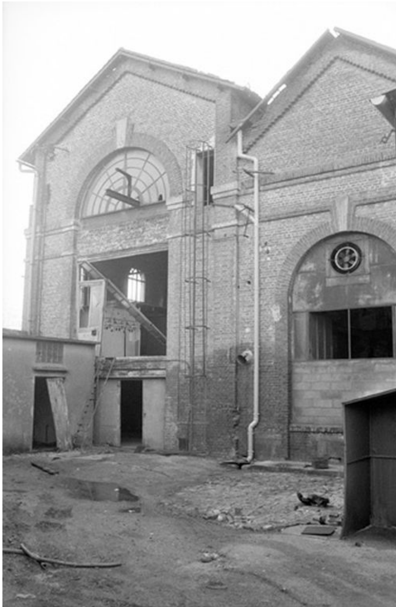
Vue de la façade nord de la salle des machines.
