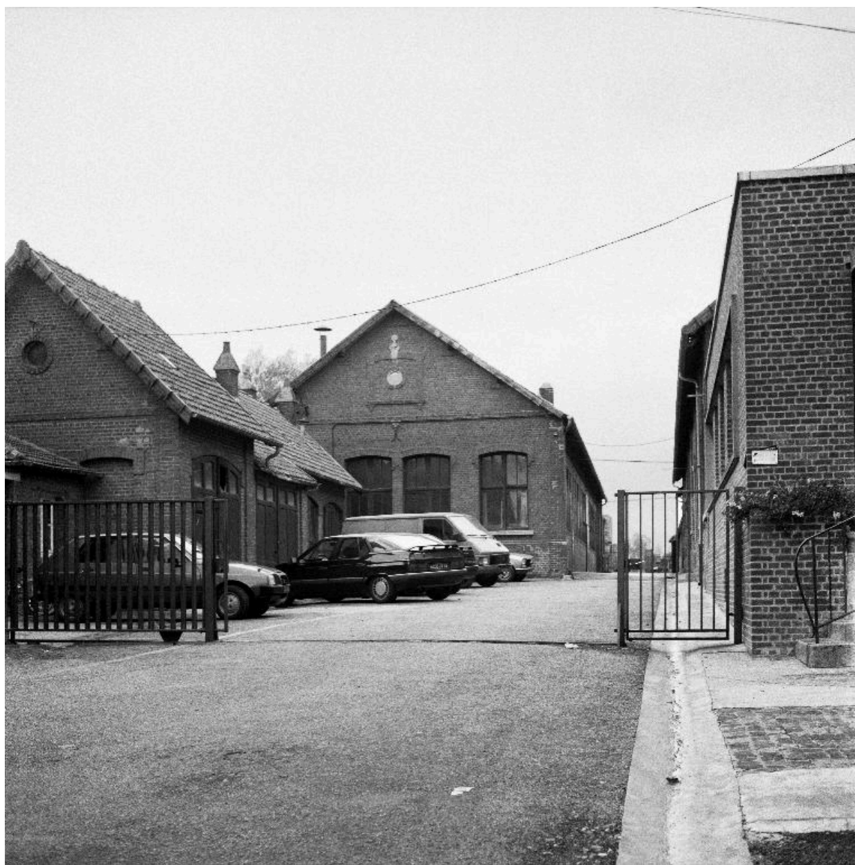
Atelier de fabrication, cantine, flanc sud-est, en 1990.
