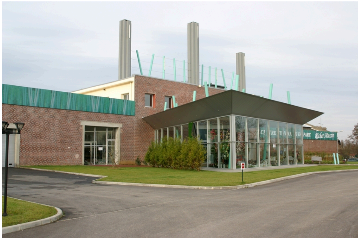
Façade antérieure de la boulangerie industrielle, reconvertie en funérarium.
