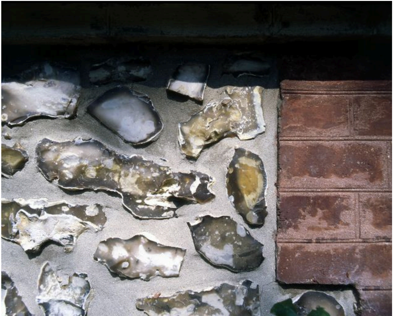
Détail de la maçonnerie du soubassement.
