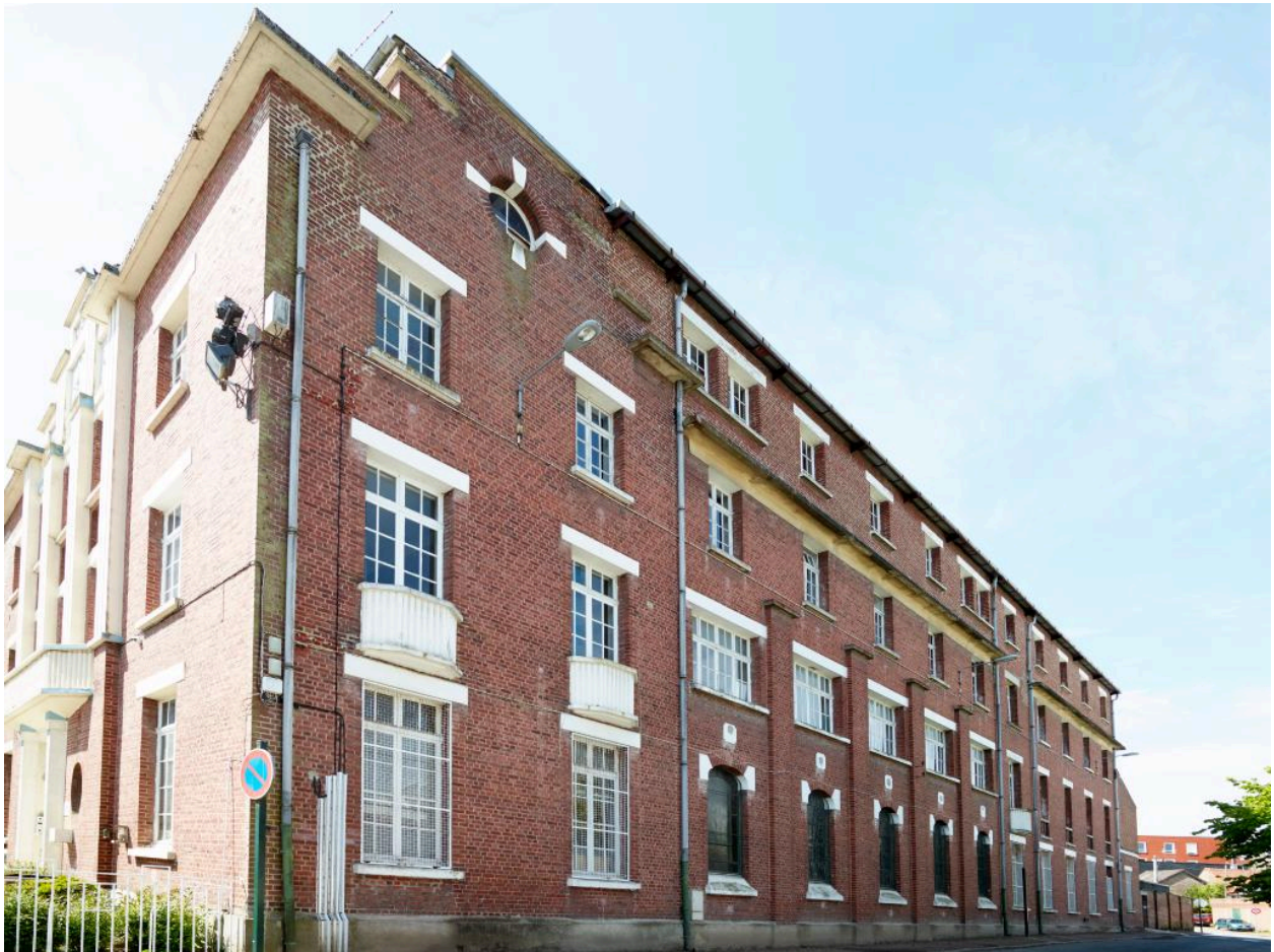
Vue de détail de la façade rue des casernes.
