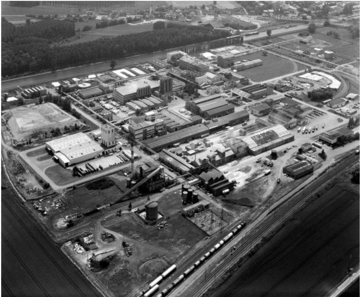
Vue aérienne depuis le nord, en 1991.
