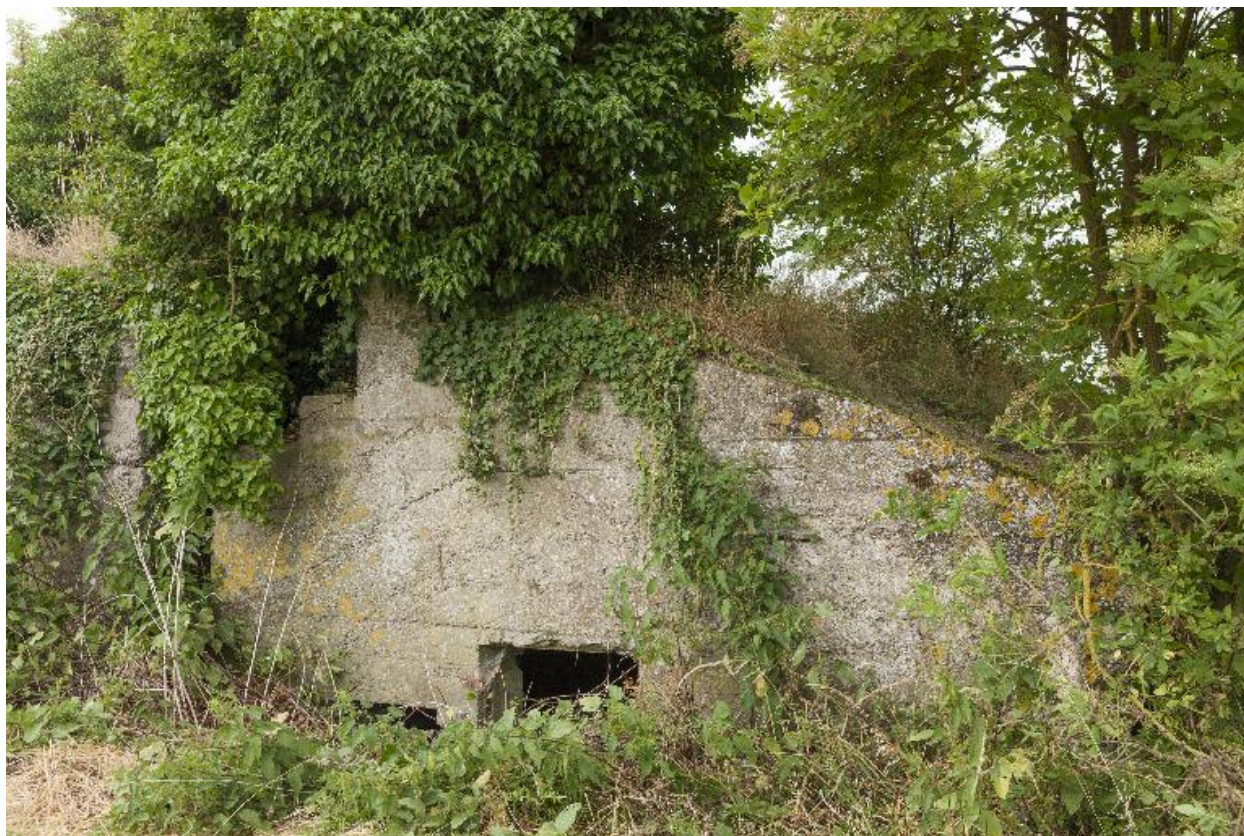
Casemate e, vers l'ouest
