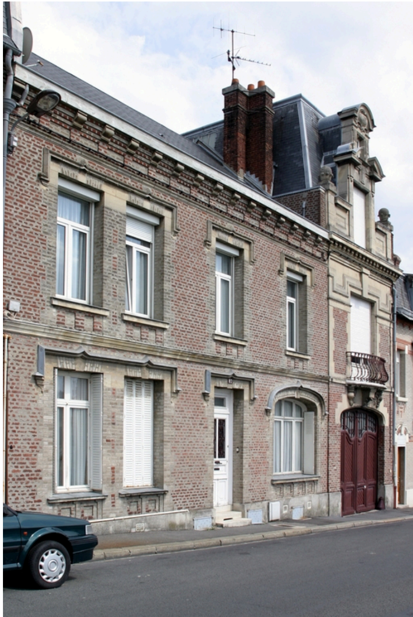
Logement patronal : façade antérieure.
