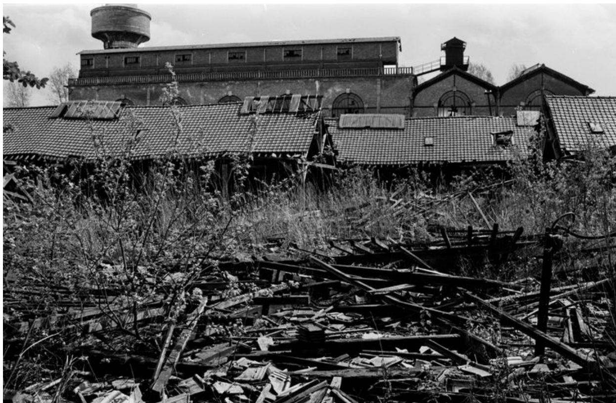
Magasin de câblerie et centrale thermique, en 1983 (Ecomusée du Beauvaisis).
