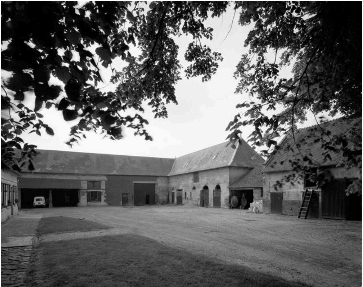
Bâtiments sur cour.
