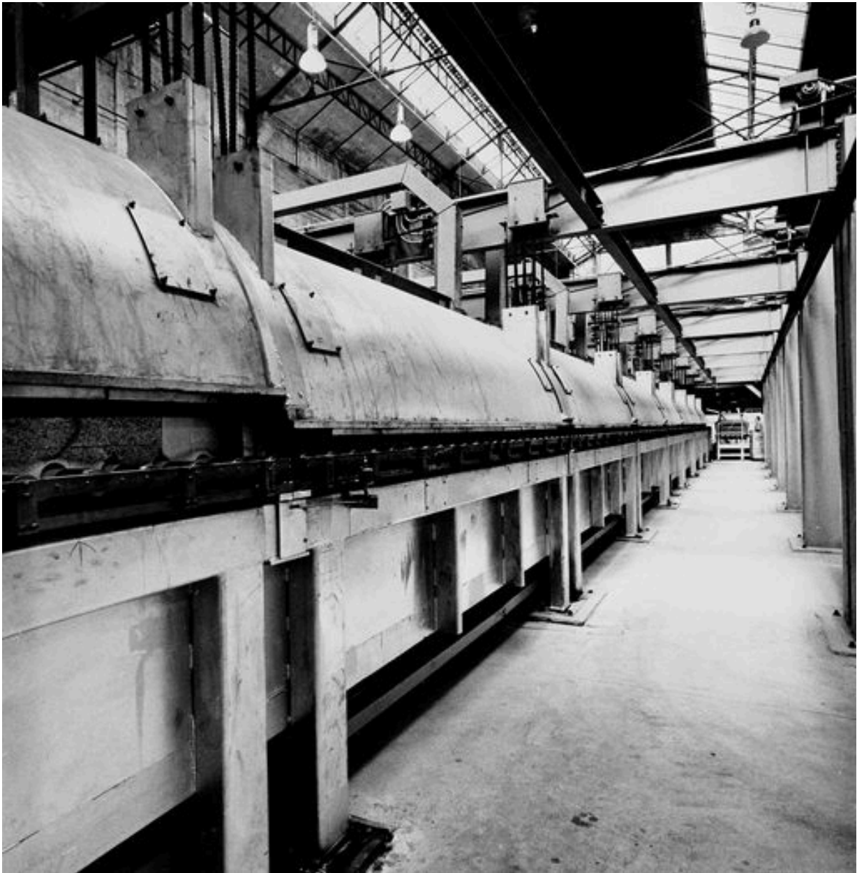
Atelier de fabrication : vue intérieure, vers 1925 (AP).
