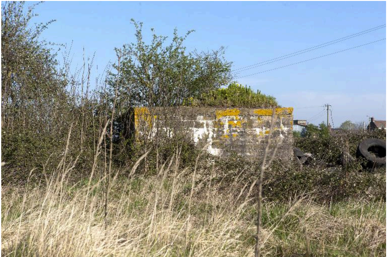
Casemate B, vers le nord
