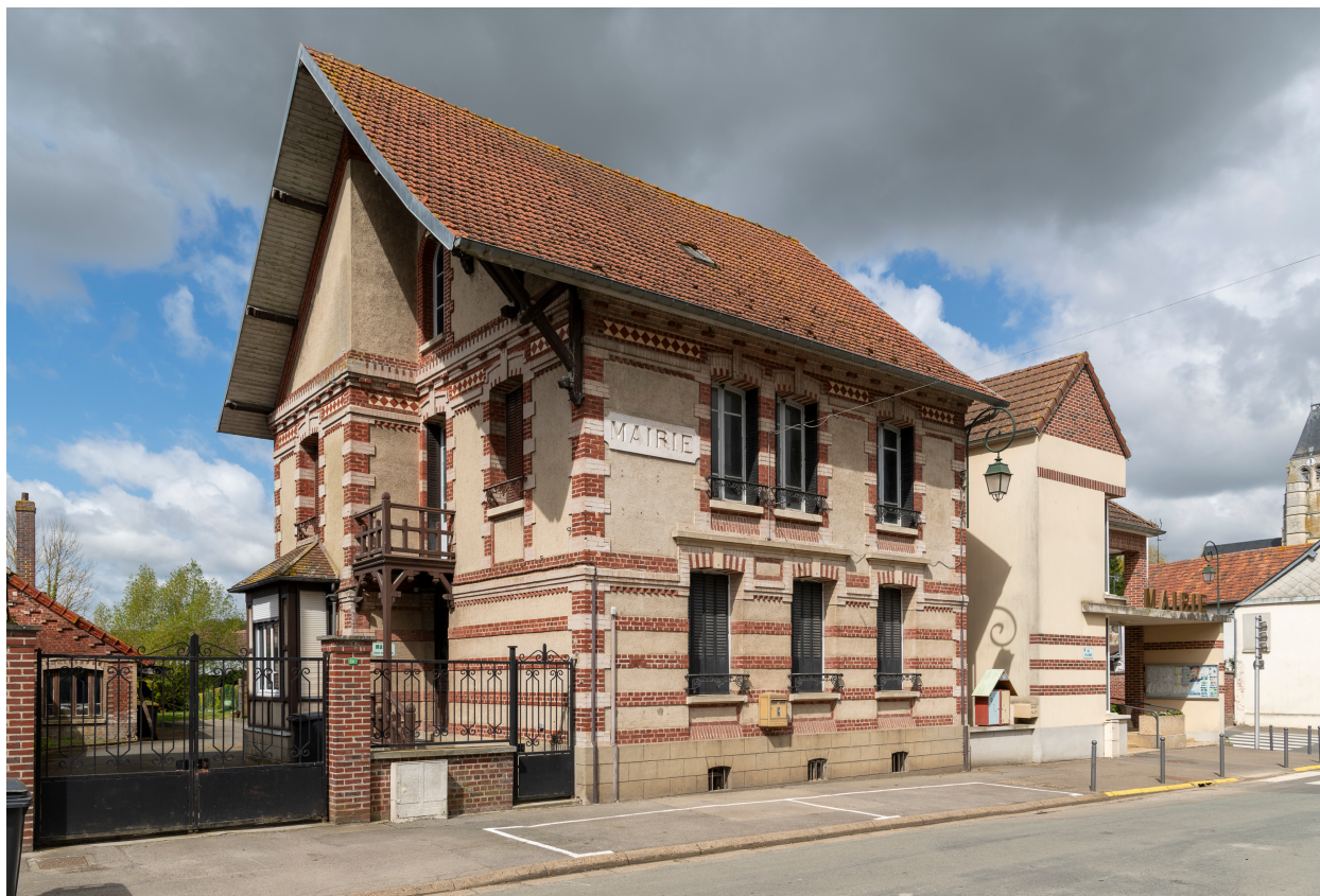
Mairie (ancienne villa "Les Pivoines"), n°2 rue de la Mairie, vue depuis le sud-est.
