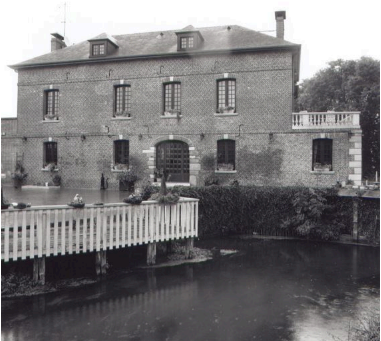
L'usine, façade ouest.
