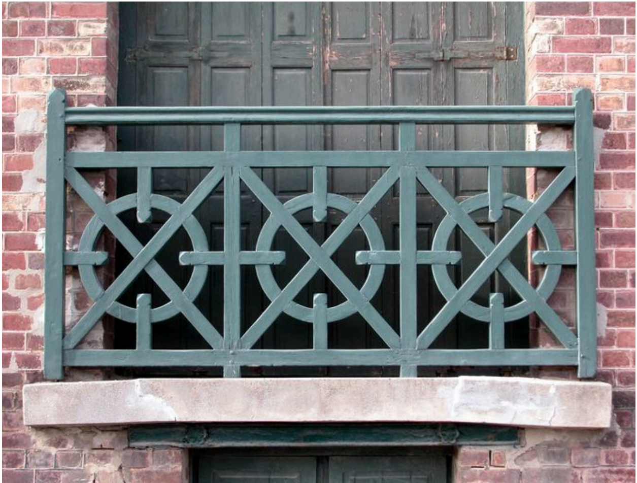
Détail du balconnet en menuiserie du rez-de-chaussée.
