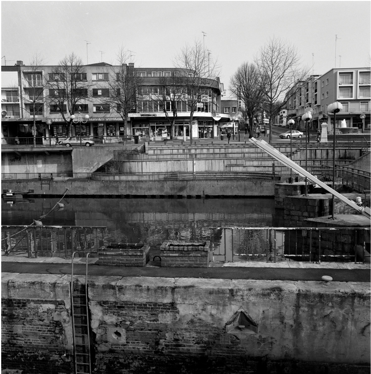
Vue générale de l'aménagement du quai de la Sambre à l'angle du boulevard.
