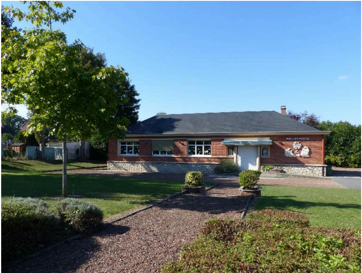
La bibliothèque, construite en 1950.
