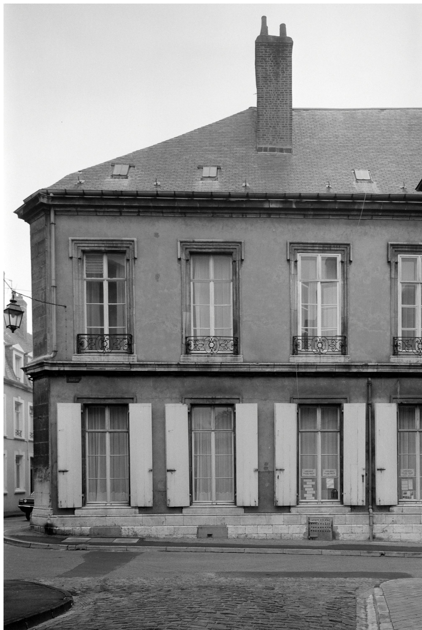
Façade, rue du Château, détail.
